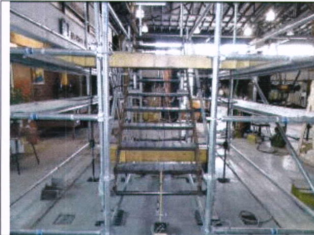
Fotografía 3.1.1: Vista general del montaje del ensayo de flexión al centro del vano de la escala.
